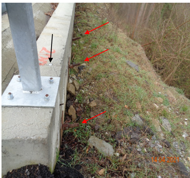
сн. 2 - геодезичен репер и анкери
