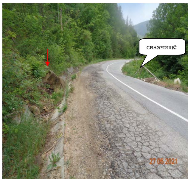
сн.2. – поглед от изток на запад на преден план-запълнената канавка
