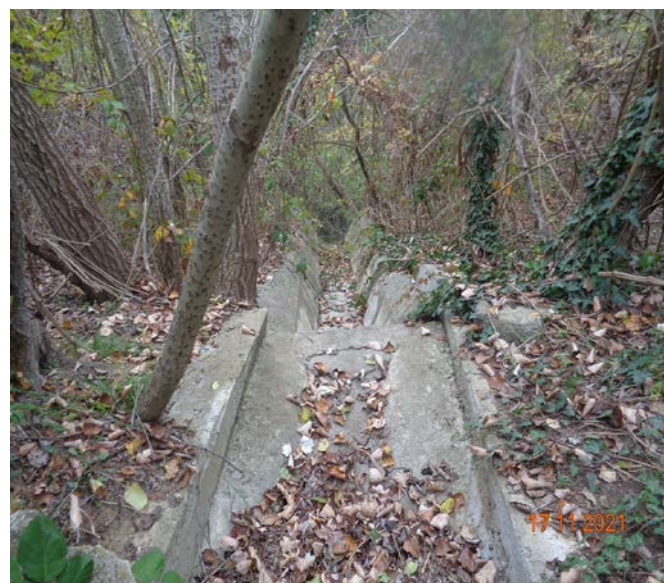
сн.4 – канавката срещу блока в имот 608
