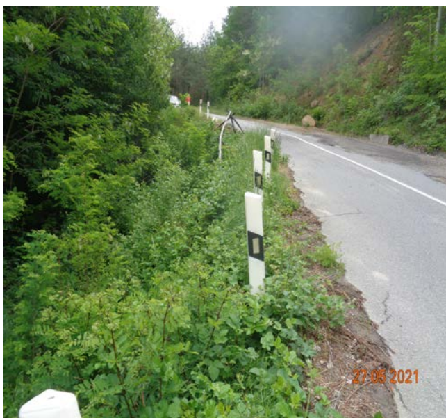
сн1. - общ изглед към свлачището поглед от запад на изток
