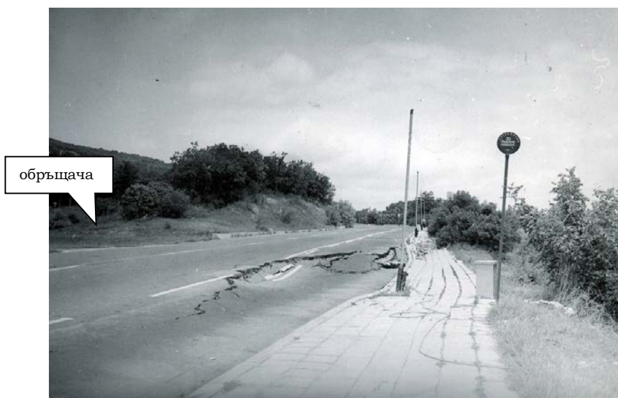
Сн.1. 25.06.1978 г. - Деформации по път I-9 от главния свладищен отстъп
