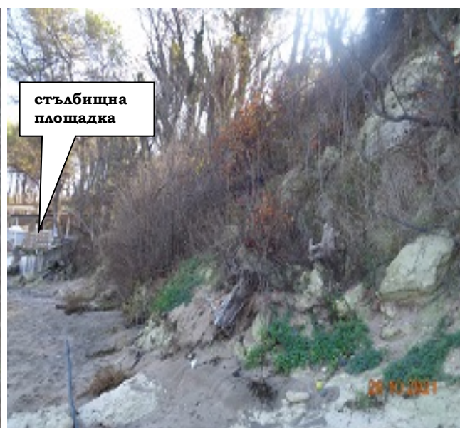
сн.4 – свличане на земни маси на плажа
