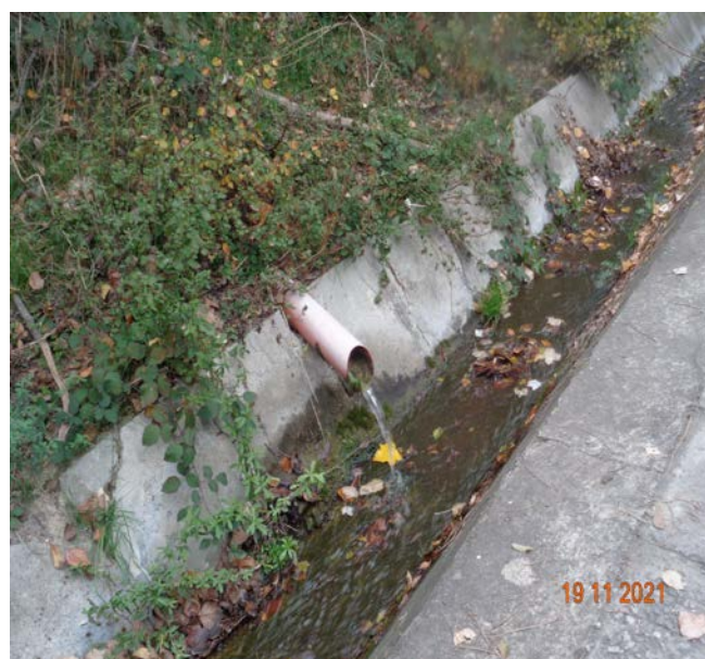
Отводнителната канавка покрай пътя към Рибарското селище и изтичалото на ВШ-2
