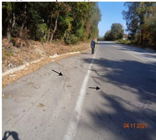
сн.6 – пукнатини пресичат пътя и се проследяват в гората над него
