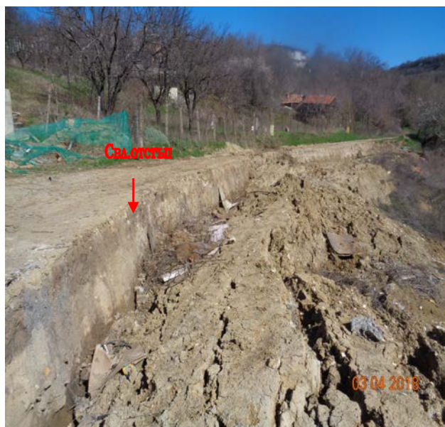
2018 г. - Главен свлачищен отстъп и ВиК авария
