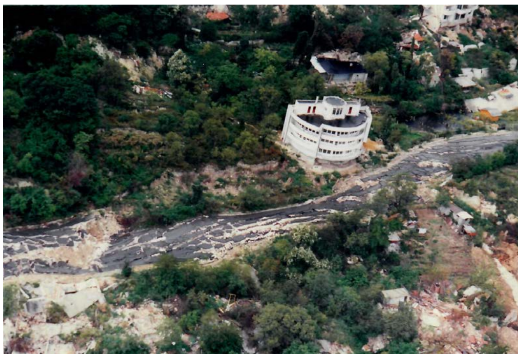
„наклонената къща“ и път IV-90023 след катастрофалното свличане през април 1997 г.
