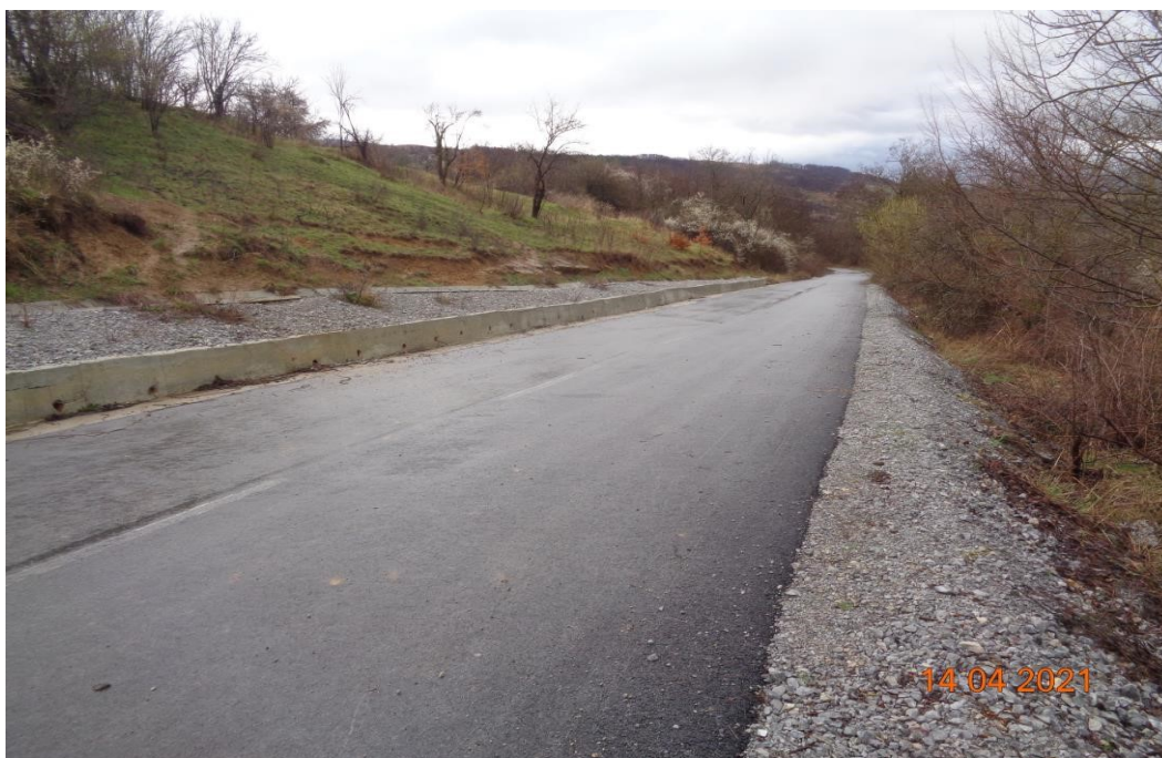
Сн 1. - общ изглед на пътя с изпълнените укрепителни мероприятия поглед от запад на изток
