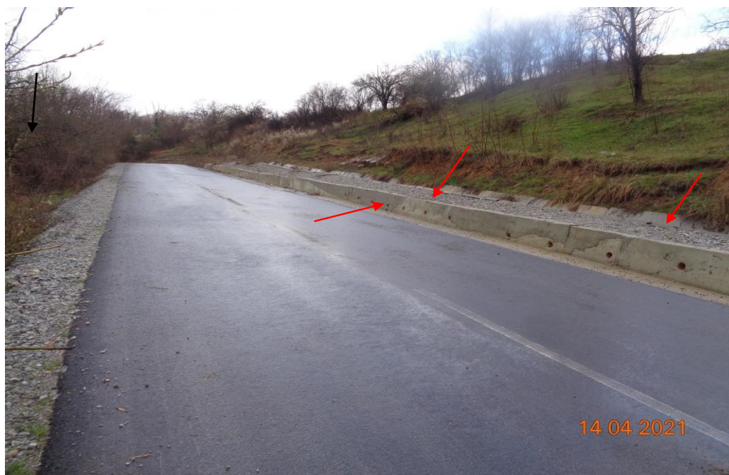
сн. 2 – общ изглед от изток на запад и изпълнените съоръжения стена с барбакани, дренажна призма, канавка
