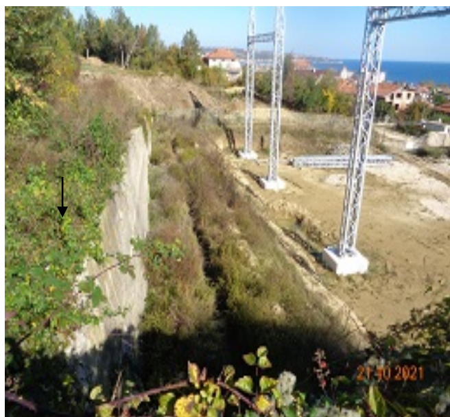
сн. 5 – подстанция в ПИ 943 и изкоп с вода
