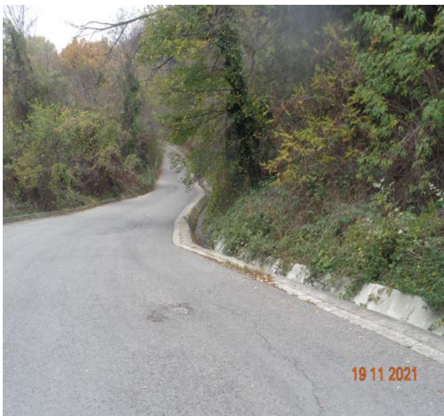
Отводнителната канавка покрай пътя към Рибарското селище и изтичалото на ВШ-2
