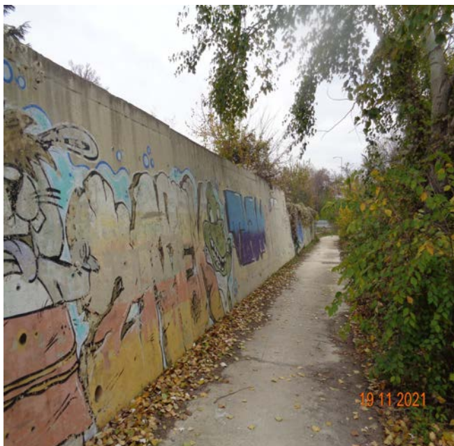
Подпорна стена и ростверк на пилотна конструкция под път I-9
