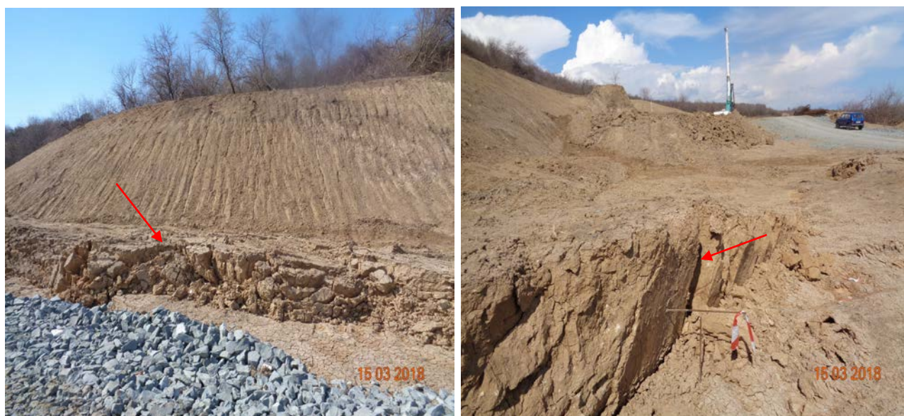
вал на изтласкване 15.03.2018г.
