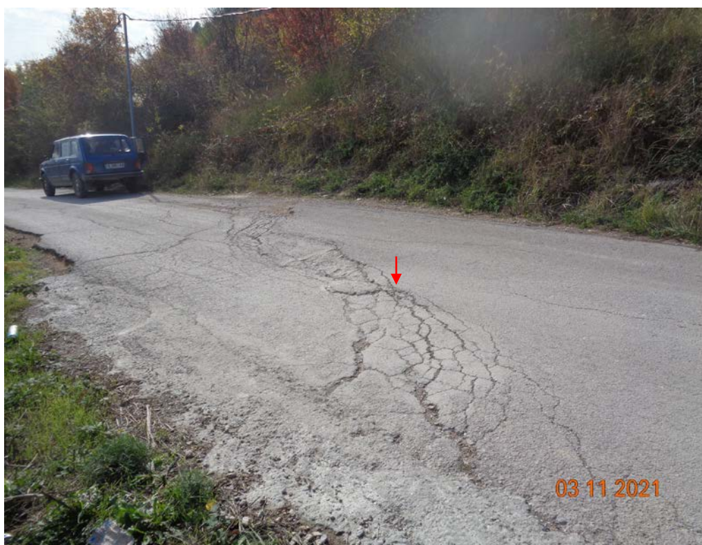
сн.1 деформация на технологичния път
