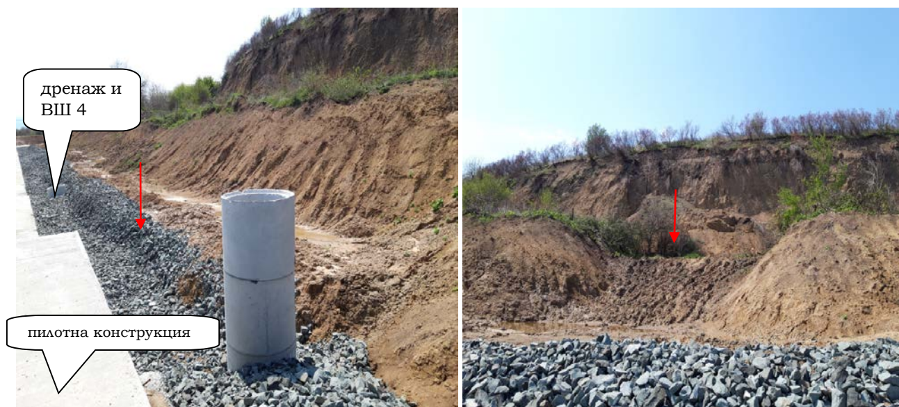
вал на изтласкване 16.04.19 г. траншея в свлачището
