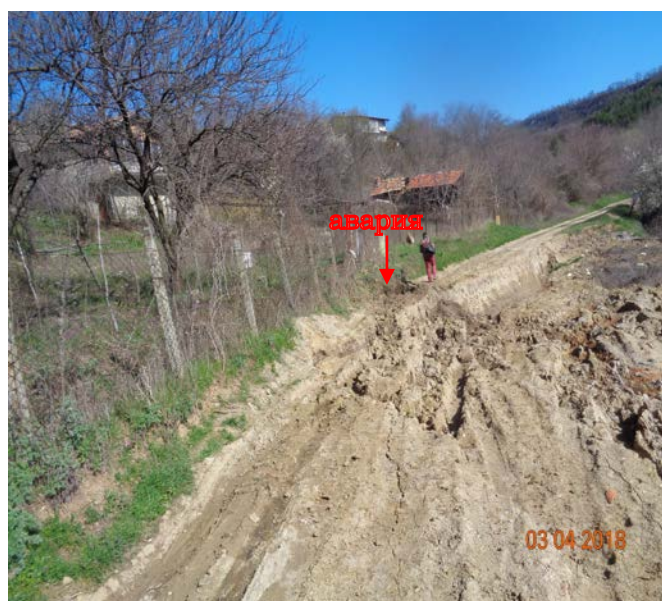
2018 г. - Главен свлачищен отстъп и ВиК авария
