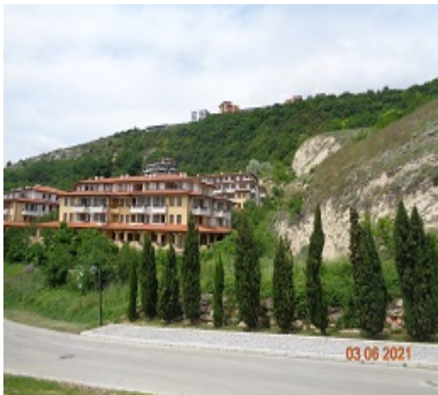
сн.3—по масивните сгради има деформации двете сгради до пътя са наклонени назад
