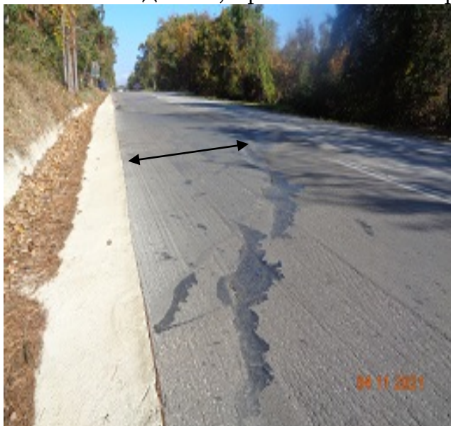
сн.5 – издуване на пътните платна
